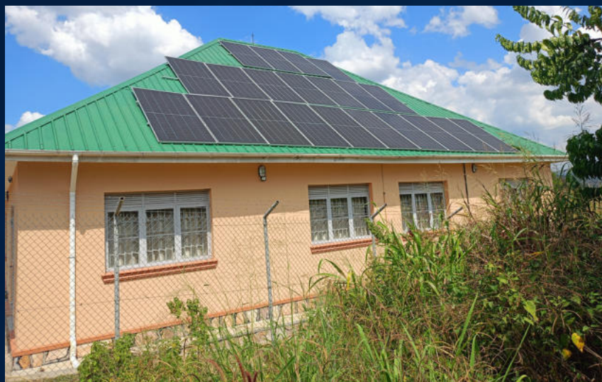
Eguzki-planta fotovoltaikoa instalatzera
