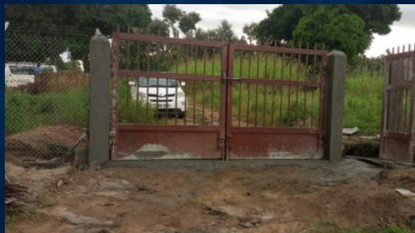
Vallado y puertas perímetro complejo
