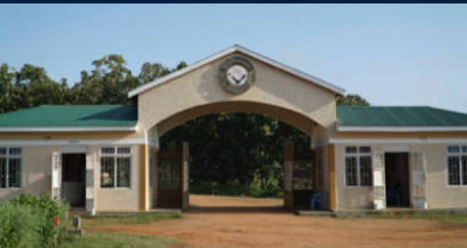
Construcción Centro Multiusos de Adjumani
