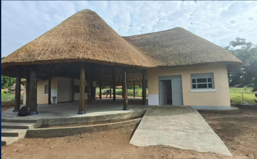
Construcción Centro de Exhibiciones
