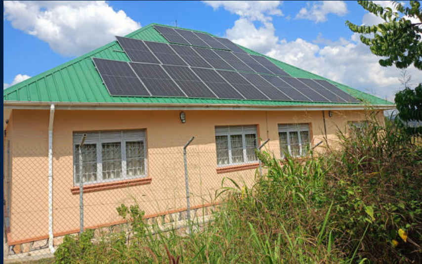
Instalación planta solar fotovoltaica
